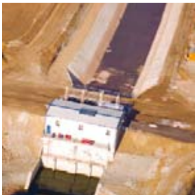
Central hidroeléctrica del Cerrato en el río Pisuerga (Palencia)
