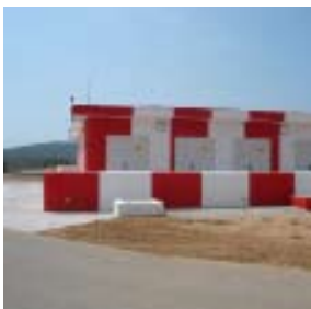
Traslado de cámaras de reguladores en el Aeropuerto de Ibiza.
