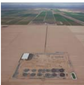
Imagen aérea de la construcción del proyecto Solana
