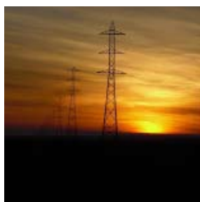
Concesión Tía María, Perú Línea de transmisión de 220 kV y ampliación subestación Montalvo (proyecto Tía María)
