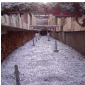
Canalización de un cable de alta tensión en la calle Puigreig de Barcelona
