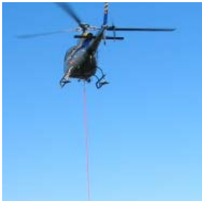
Tendido piloto, con helicóptero, de LAT en España
