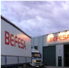
Instalaciones del área de gestión de residuos industriales en Ajalvir (España)
