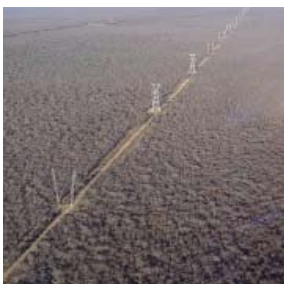
ATE II. Torres de la LT en 500 kV de ATE II Ribeiro Gonçalves (Piauí) – São João do Piauí (Brasil)
