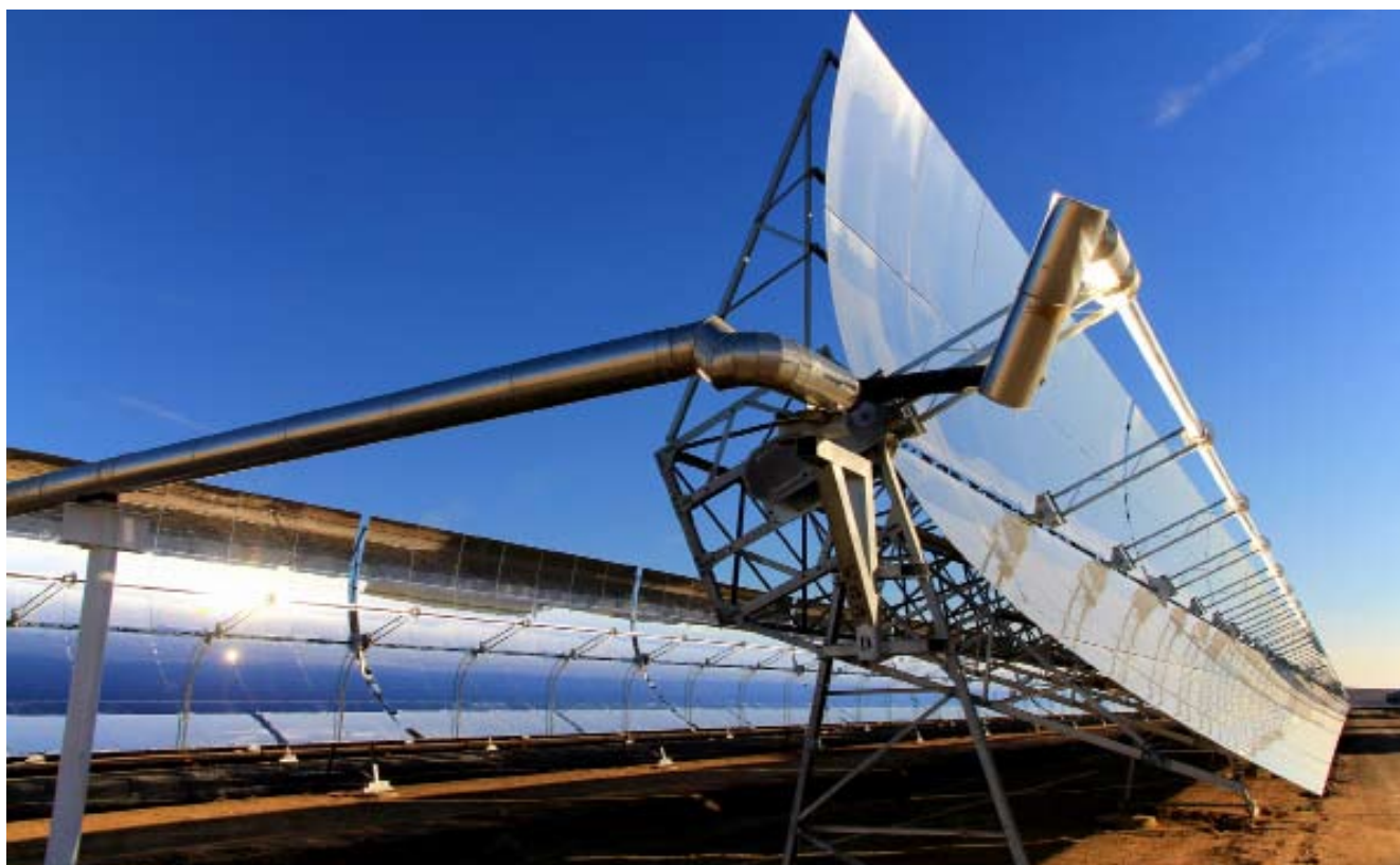
Espejos cilindroparabólicos
