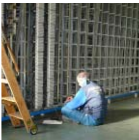
Operario en trabajos de mantenimiento.
