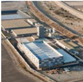
Planta desaladora de Bajo Almanzora (Almería)
