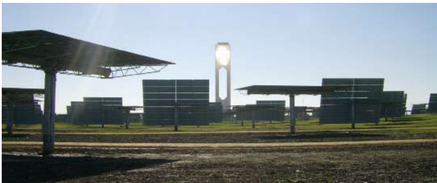
PS20 Central termosolar de torre en Sanlúcar La Mayor (Sevilla)
