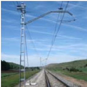
Catenaria realizada por Abengoa
