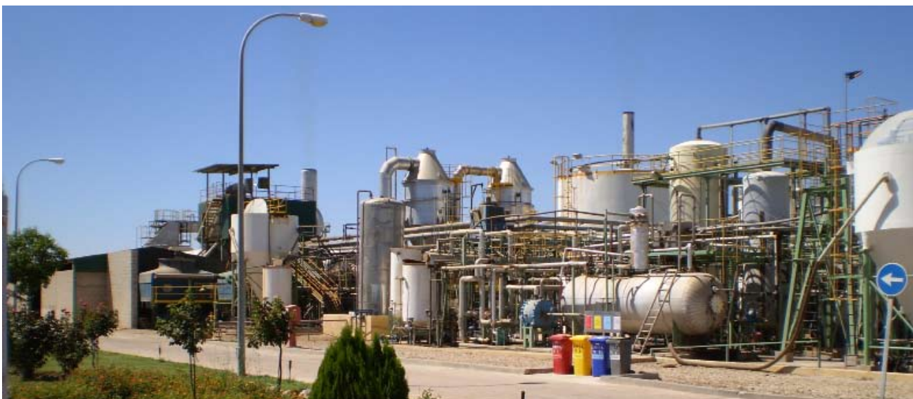
Planta de cogeneración Procesos Ecológicos Vilches.
