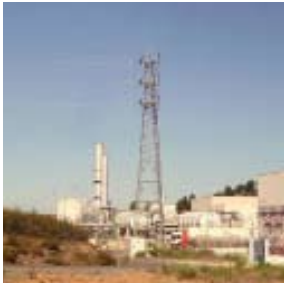
Cogeneradora Enernova en Ayamonte (Huelva).
