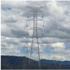
Concesión LT Carhuamayo, Paragsha, Conococha, Huallanca, Cajamarca, Cerro Corona, Carhuaquero LT 220 kV Conococha – Kiman Ayllu – L3 Proceso de Tendido (Perú)
