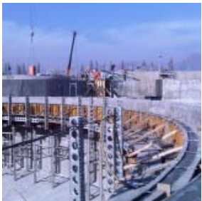
Construcción de la planta de tratamiento de Riles, Planta Quilicura, Chile.
