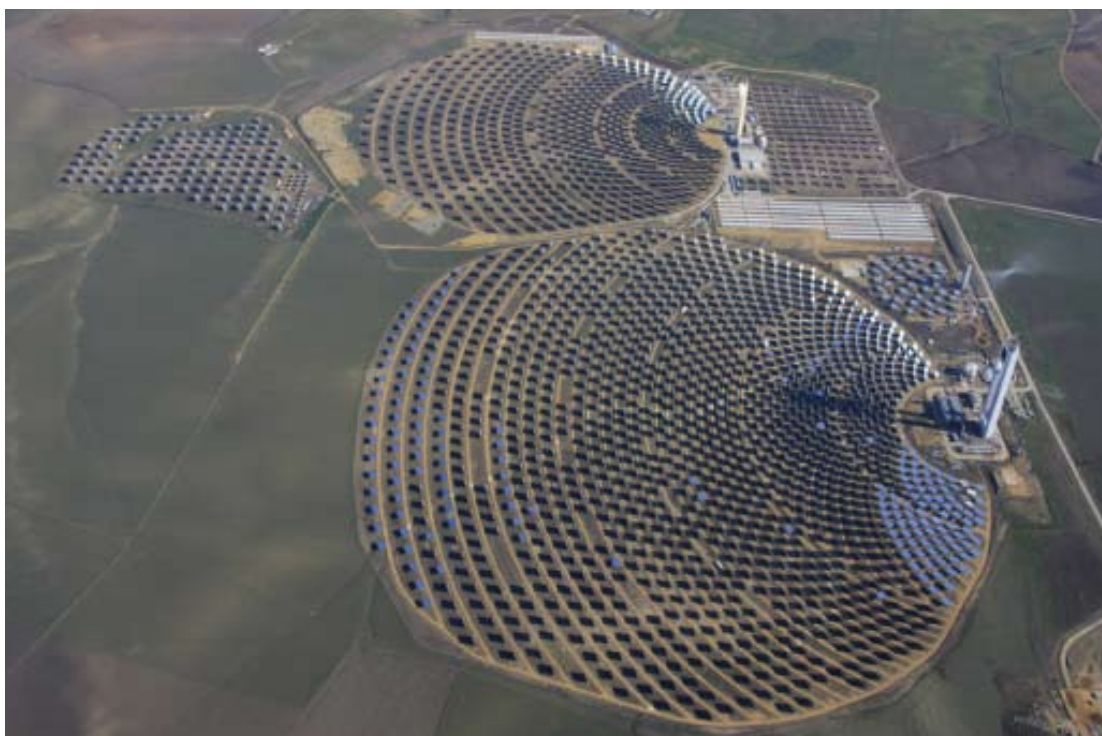
Plataforma solar con instalaciones de diversas tecnologías
