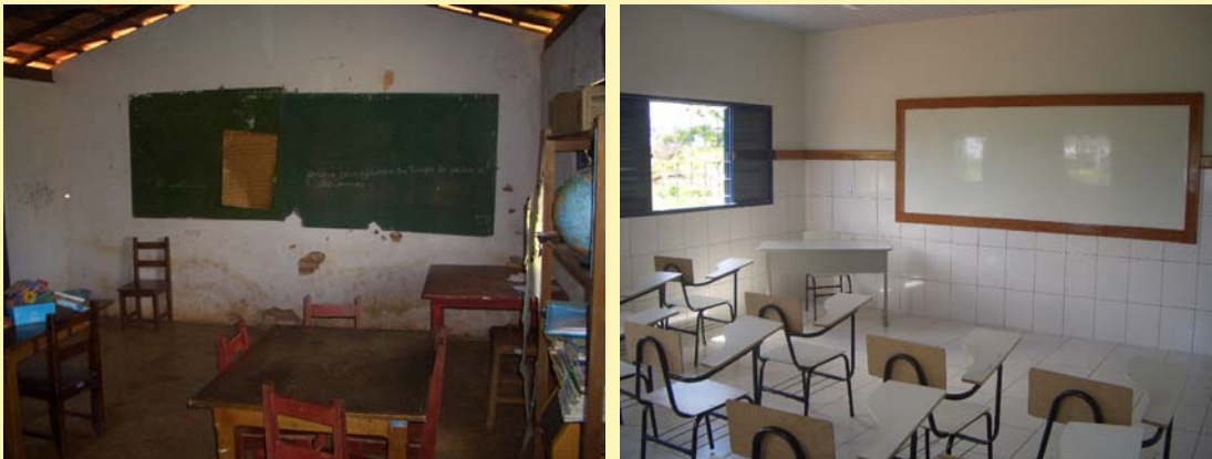
Escuela Municipal de Santa Clara antes y después de la reconstrucción
